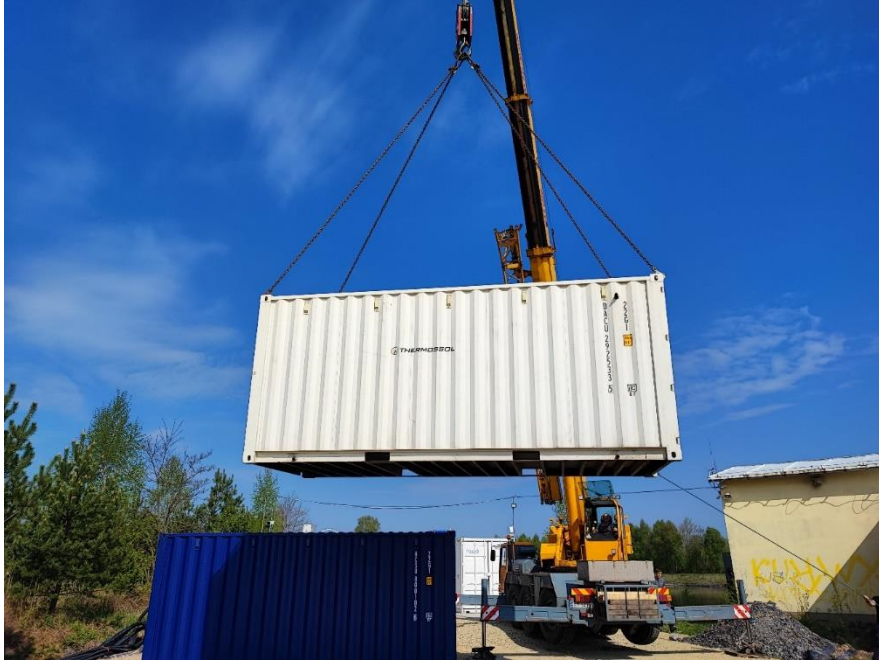
Εικόνα 3: Τοποθέτηση του εξατμιστήρα
